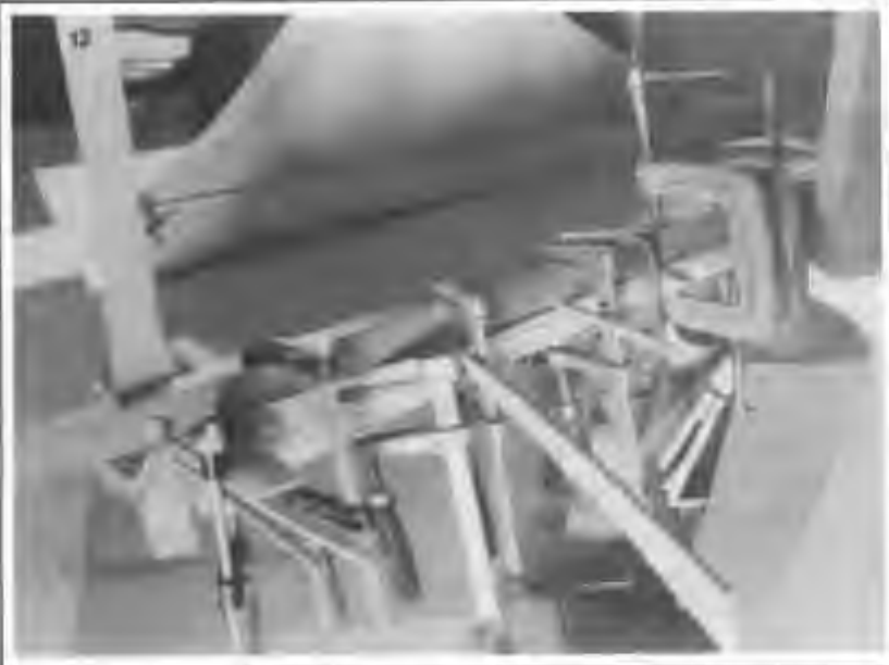
Construction du 1 er élément vertical. Les tranches des bords sont prêtes à recevoir les deux autres parois.
