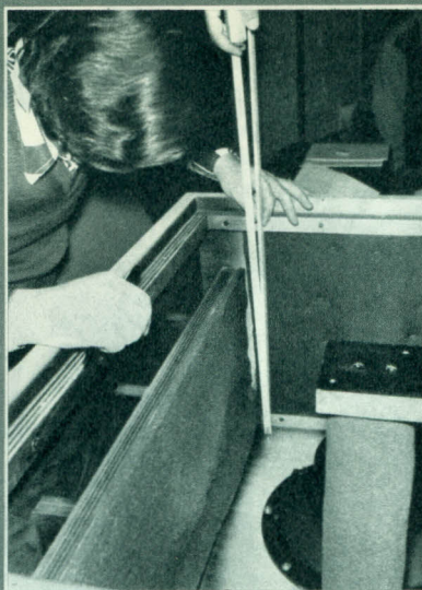
⇨測定・試聴しながらダクトを調整する
