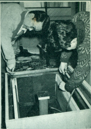
⇨測定・試聴しながらダクトを調整する
